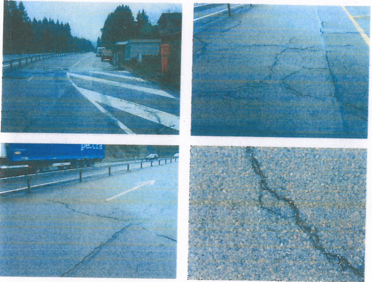
Figura 4 – ca. km 42.3, degrado pavimentazione area di sosta Isola SN e NS
